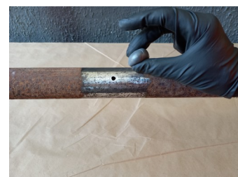
Aplicação da massa epóxi
