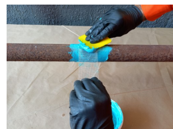
Aplicação do sistema de laminação no tecido
