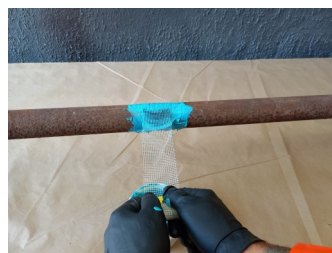
Tensionamento do tecido
