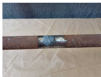
Massa epóxi aplicada
