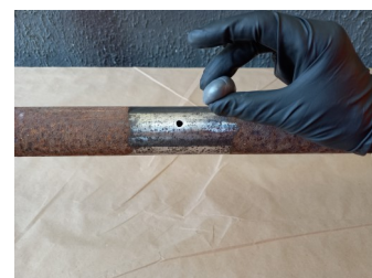
Aplicação da massa epóxi
