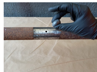
Aplicação da massa epóxi
