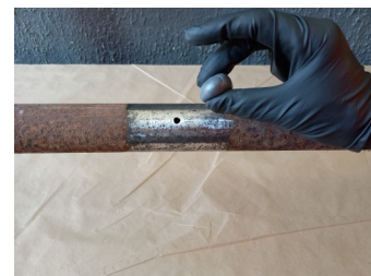
Aplicação da massa epóxi
